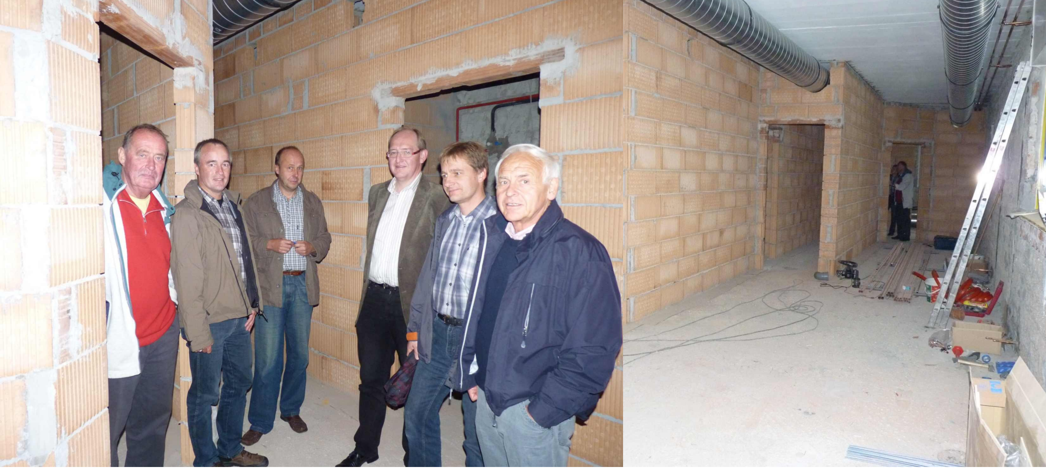
September 2010: Baustellenbesichtigung. Für den 2. Bauabschnitt mit der umfangreichen Sanierung und Umgestaltung des Umkleide- und Sanitärbereiches bleibt das Schwimmbad für 6 Monate geschlossen
