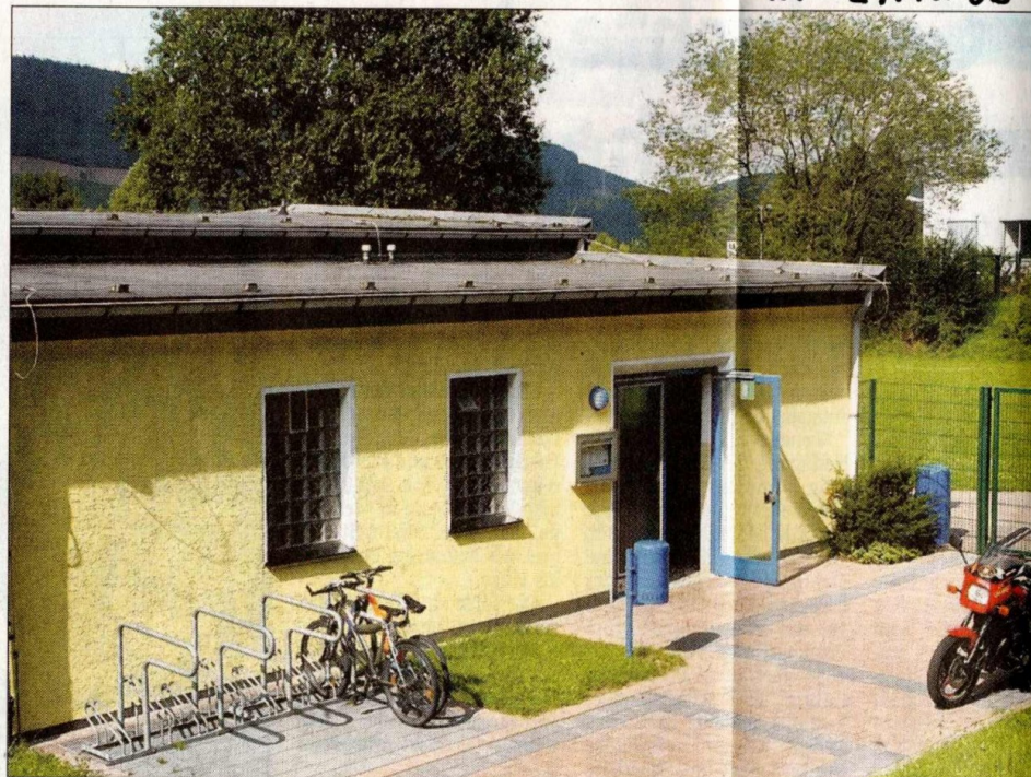
Die neue Fassade des Velmeder Schwimmbades strahlt förmlich: Der Förderverein der Wasserfreunde hat hier ganze Arbeit geleistet.
